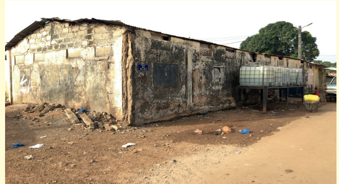
Das ist der aktuelle Zustand auf dem Grundstück.
